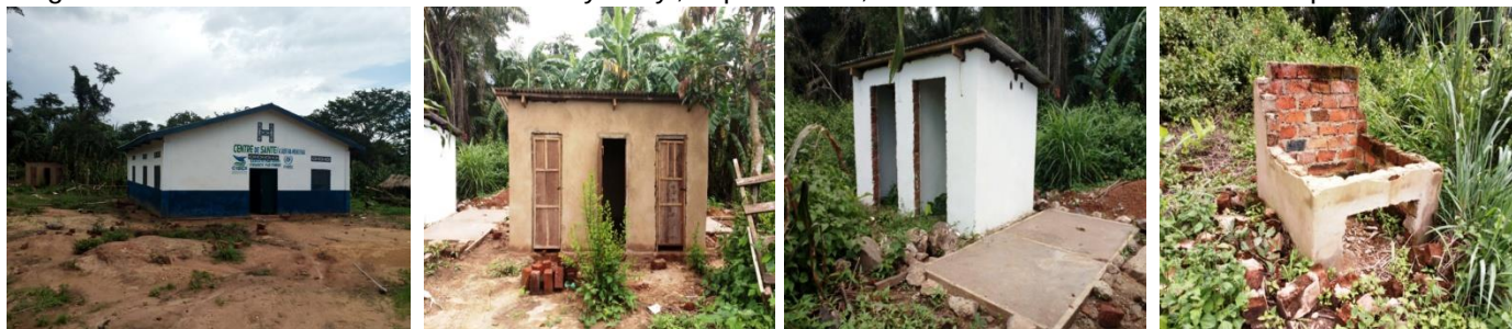
De gauche à droite : Bâtiment du CS Kabeyamukena, trois portes de latrines, deux douches et incinérateur en cours de construction. Photo prise le 29/12/2018.
