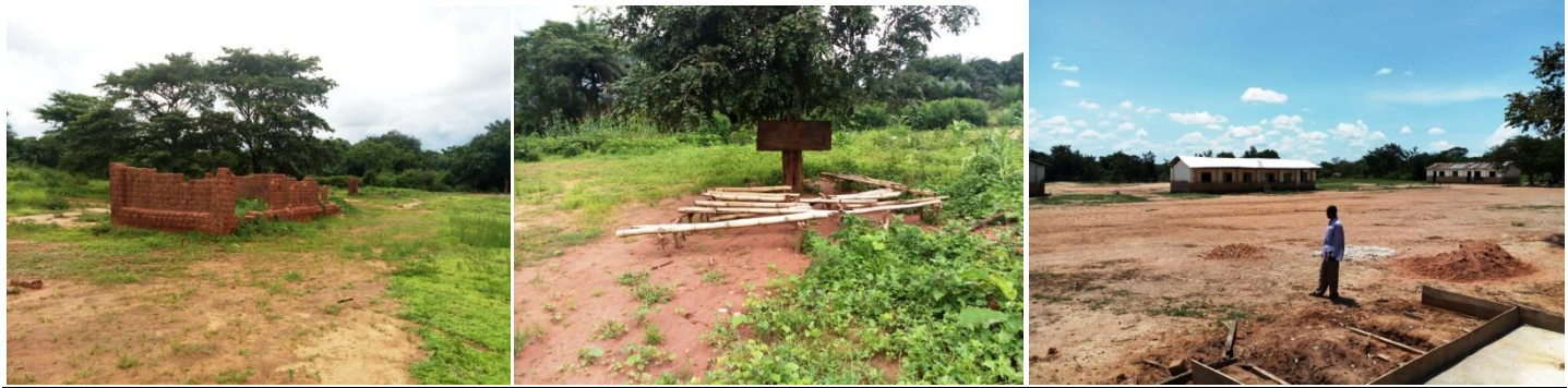
De gauche à droite : le décombre de l'EP Kasongo incendiée en septembre 2017, Classe sous arbre de l'EP Kasongo avant la récente crise et EP Leya de Kabeyamukena en réhabilitation de la toiture. Photo prise, le 27/12/2018.
