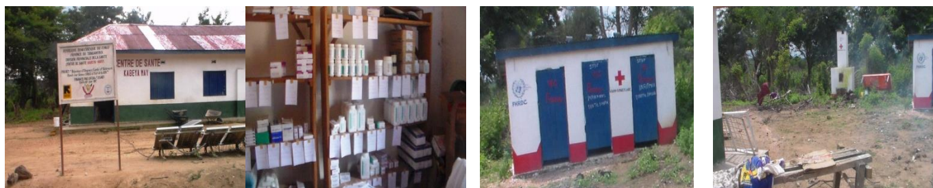
De gauche à droite : le bâtiment du CS Kabeyamayi, la pharmacie, les latrines et incinérateur. Photo prise le 28/12/2018
