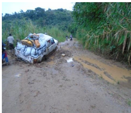
Ombrage de végétation, Eaux stagnantes et Bourbier sur le Tronçon Nyabiondo- Kashebere-Kibua
