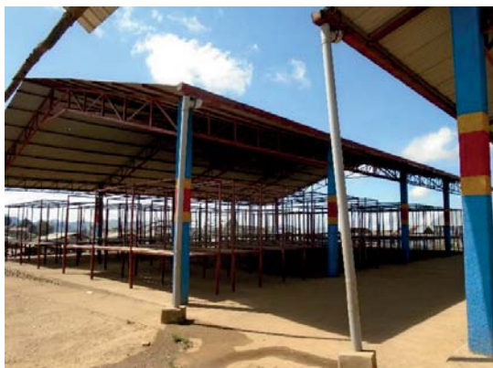
Marché de Kipese (réhabilité)
