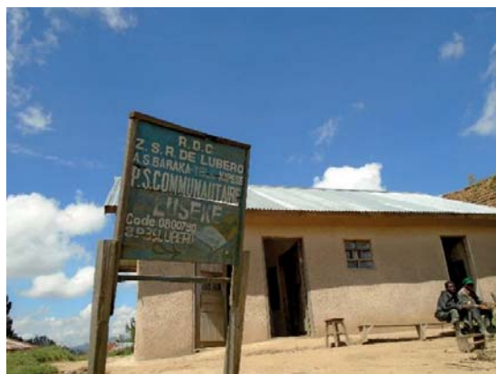
Poste de santé Luseke/Aire de santé de Baraka
