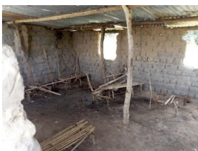
Vue intérieure de l'Institut3 BANZEBE/MUONGO
