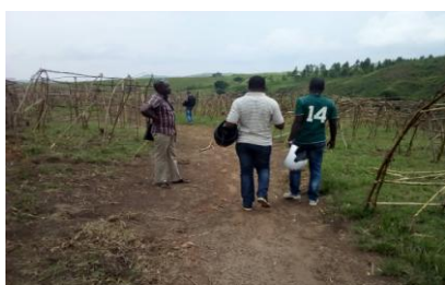
Les tentes en construction par les déplacés
