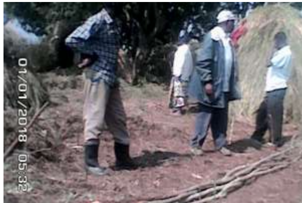
Site en pleine construction
