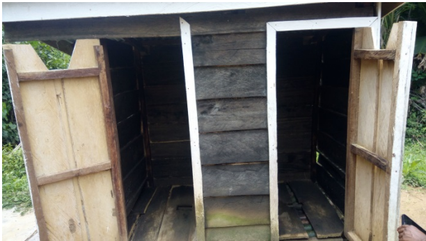
LATRINE DU CS CHAMBUCHA
