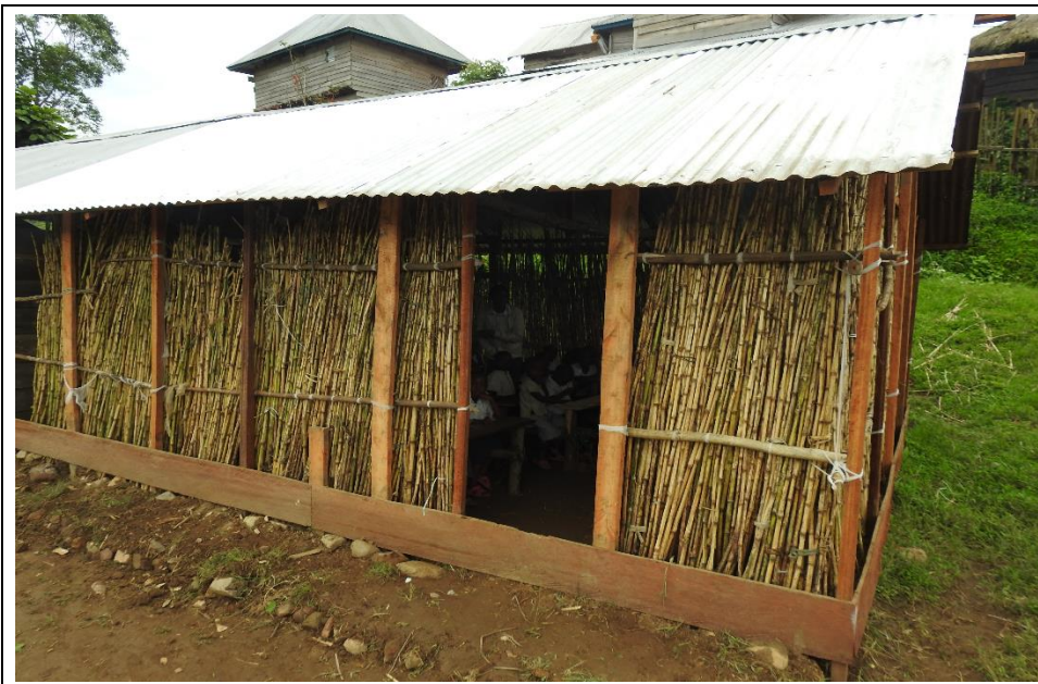
Figure 10 : état d'une école nouvellement construite par la communauté
