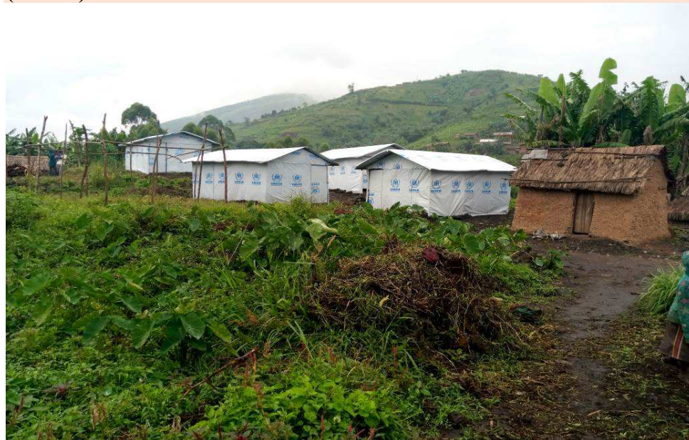
Photo de quelques abris d'urgence prise dans le site Kalonge
