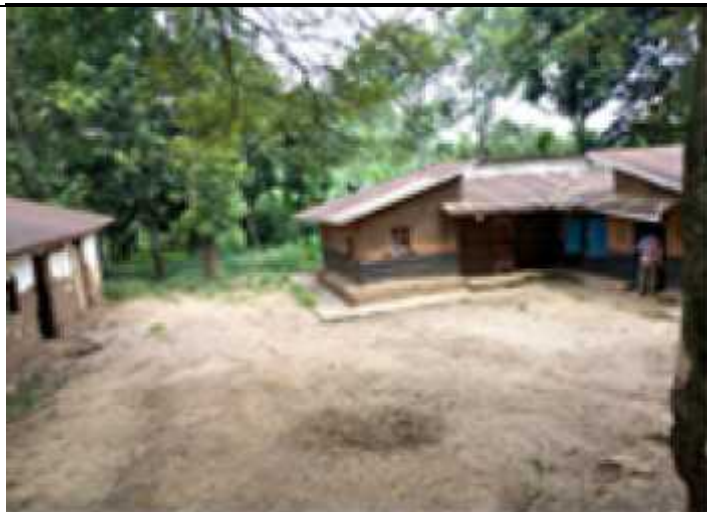
EP NDAGHO détruites, elle évolue dans des pièces de l'ancien poste de santé de Kibingu
