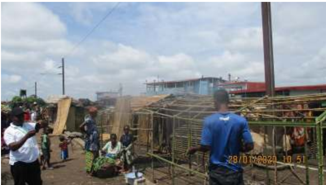
Abri de fortune en construction
